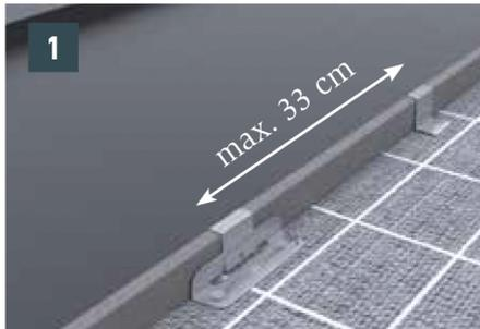
Im Bereich der Modulfläche (siehe Abb. 7) darf der maximale Haftabstand von 33 cm Mitte Haft zu Mitte Haft nicht überschritten werden.
